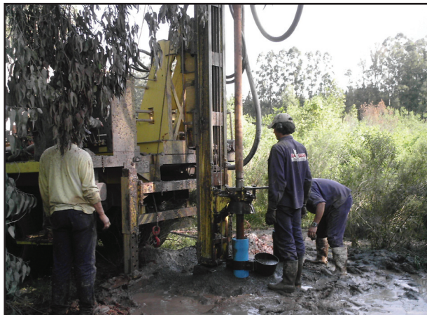
Perforación de pozo de agua subterránea
