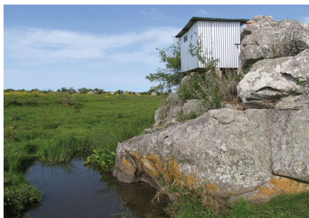
Estación de monitoreo en arroyo Puntas del Pantanoso. Contiene la estación meteorológica, el equipo programado para tomar muestras de agua del arroyo en forma automática, y las baterías que alimentan estos equipamientos
