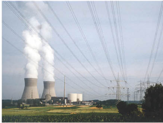
Torres de enfriamiento de la planta nuclear en Grundremmingen, Alemania. Foto: IAEA.org Image Bank
